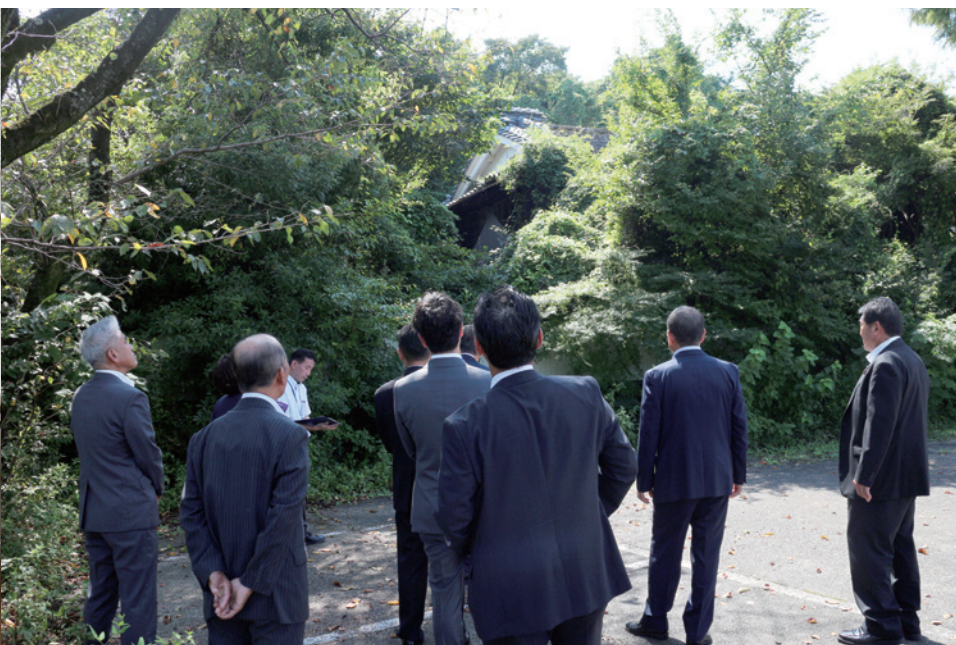
◀寄附を受ける名森小学校東(大明神地内)の空き家
