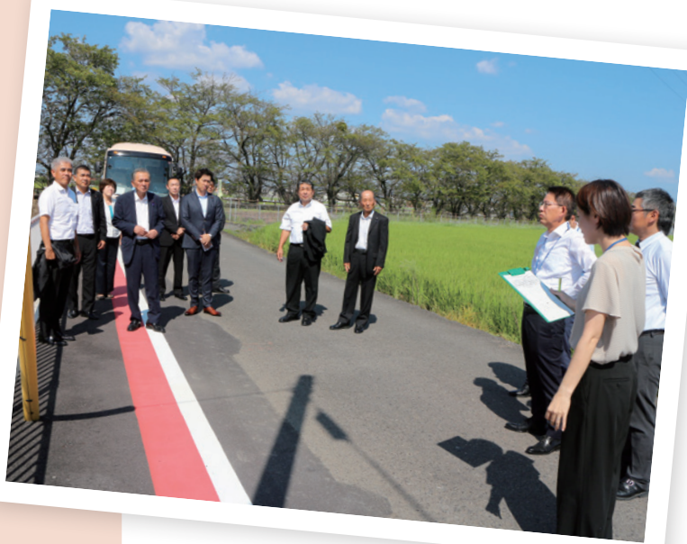
▲道路改良工事が完成した外善光地内
