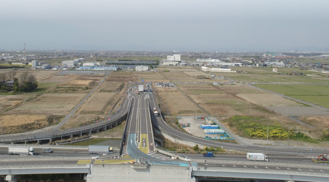
◀造成工事が始まる 安八SIC周辺
