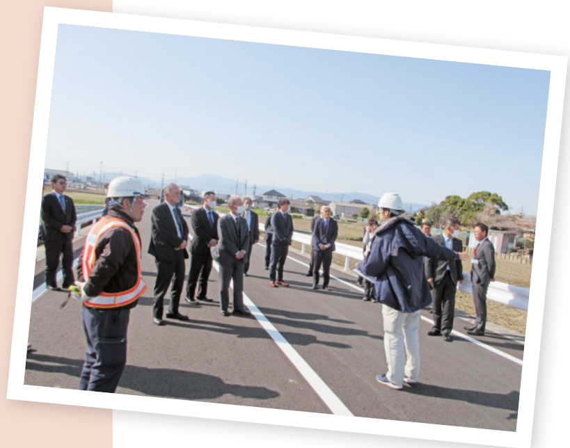
▲舗装工事が完成した県道間アクセス道路 (3月23日開通)
